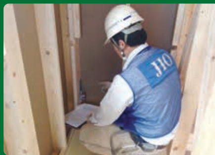
躯体工事の完了時
