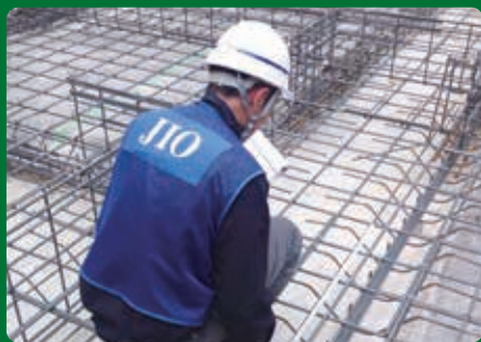
基礎配筋工事の完了時
