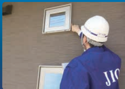
建物本体工事完了時
