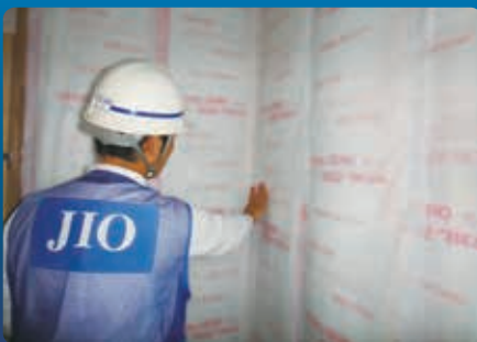
断熱材施工時
